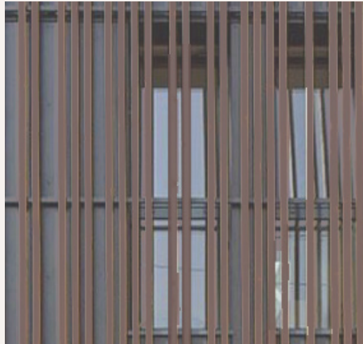
Solavskärmning med vertikal karaktär
